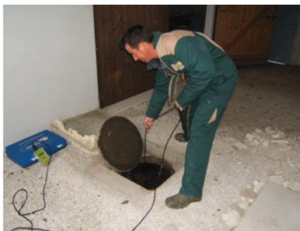
(Mesure de boues d'une fosse septique)
