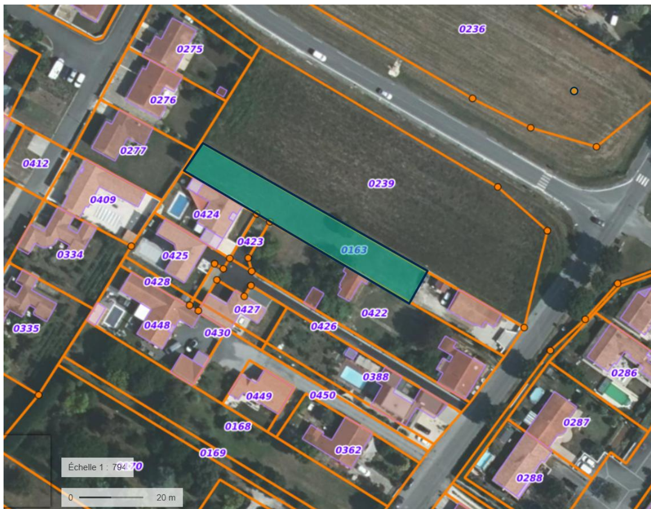
Vue aérienne de la parcelle AH 163 et du secteur concerné par l'erreur manifeste d'appréciation
