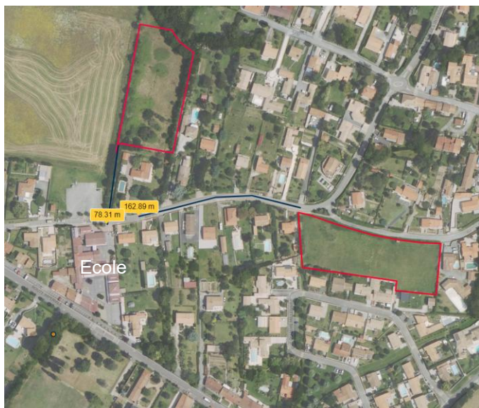
Vue aérienne des périmètres OAP rue des carrés et rue de l'intendance et distance vis-à-vis de l'école
